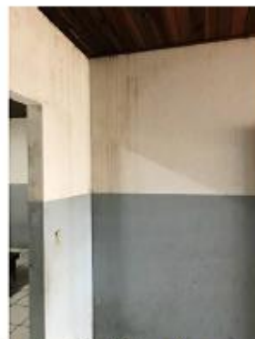
Paredes do refeitório com infiltrações
