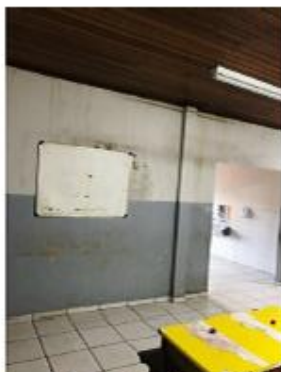
Paredes do refeitório com infiltrações
