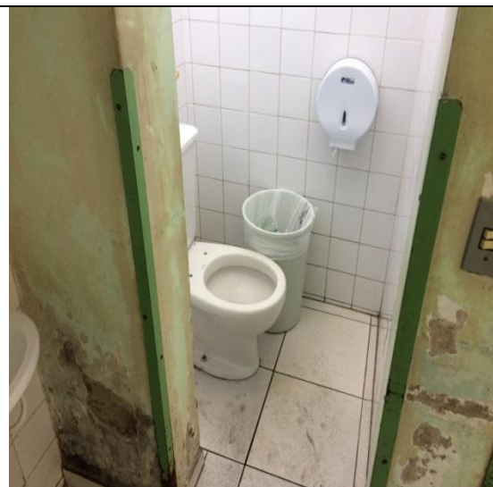
Equipamentos aguardando manutenção
